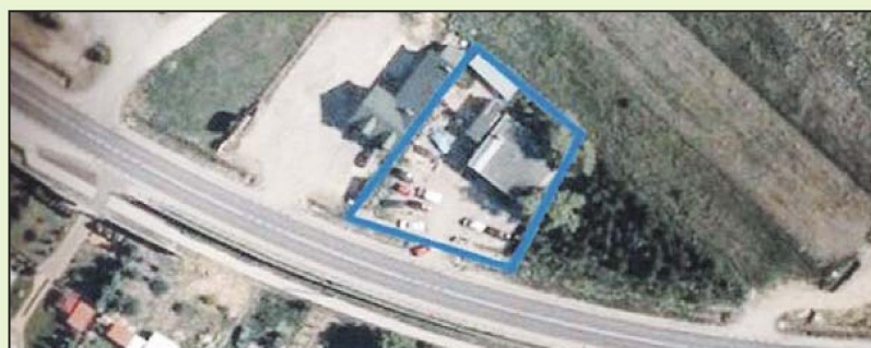
Lokalizacja inwestycji. Budynek pow. 176,4 m²
